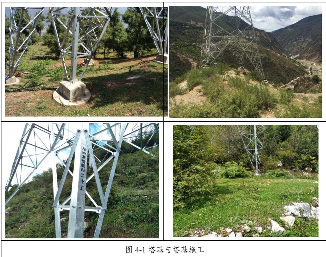
塔基防治区、塔基施工临时防治区两区域施工场地紧密相连，按原方案设计对塔基实施表土剥离、绿化覆土措施，对施工迹地实施撒播草籽措施，目前恢复良好。同时，针对部分塔基（N22、N23）实施堡坎、部分塔基（N27、N29）实施浆砌石排水沟。
